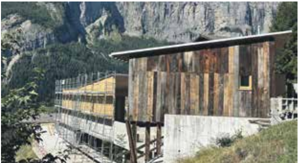
Im unteren Bereich der Bushaltestelle entsteht eine Einstellhalle.
